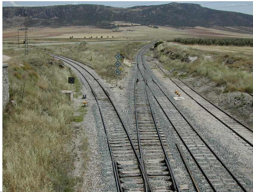
Figura 2: Estación de Moreda, dirección sur (Granada / Almería).
